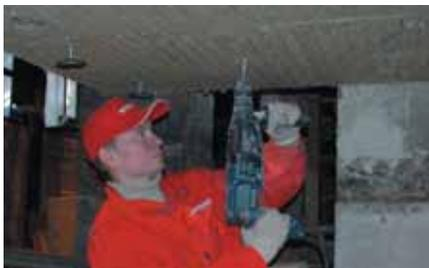
*Вставить в пробуренное отверстие анкерный элемент IDMS с предварительно одетой на него шайбой IDMS-T и ударами молотка вбить его таким образом, чтобы шляпка анкерного элемента плотно зафиксировала минераловатную плиту FT Barrier*
