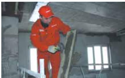
*Подготовленная часть облицовки прикладывается со стороны полки двутавра и фиксируется при помощи гвоздей с закреплением в части облицовки, расположенных со стороны стенки двутавра.*
