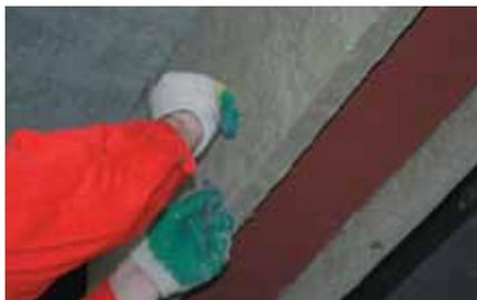
*На ту часть облицовки, которая предназначена для монтажа со стороны полки двутавра наносится клей CONLIT GLUE™ как на торцевые части, так и на лицевую*
