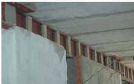
На лицевую сторону закрепленных вставок с одной стороны стенки двутавра наносится клей CONLIT GLUE™ слоем не менее 2 мм толщиной
