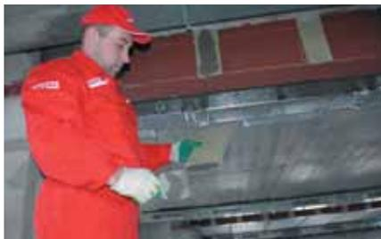
Вставки закрепляются в распор между полками двутавра. При этом вставки должны немного выступать за концы фланцев.
