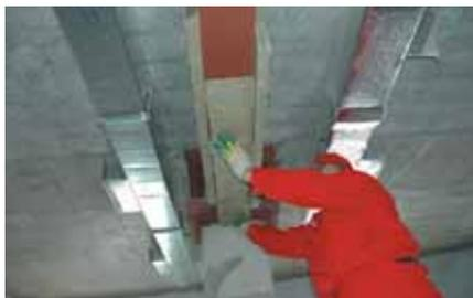
*После высыхания клея гвозди удаляются, либо их шляпки укрываются слоем клея Conlit Glue*
