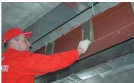
Заготовленные заранее части основной огнезащитной облицовки крепятся к вставкам при помощи гвоздей. Гвозди фиксируют облицовку на время высыхания клея. Их количество составляет 2-3 шт. на вставку.
