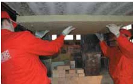
*С помощью соответствующего перфоратора подготовить отверстия из расчета 5-ти отверстий на одну плиту FT Barrier.
