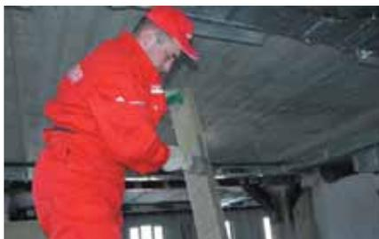
Подготовленные части облицовки с нанесенным на них клеем фиксируются со стороны полок двутавра на уже смонтированные плиты при помощи гвоздей. Длина гвоздей должна быть в 2 раза больше толщины применяемого материала
